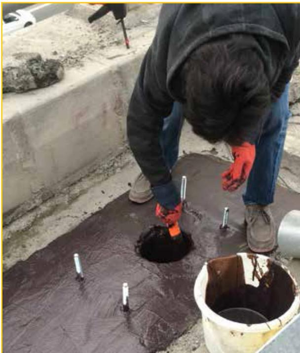
Vand Tar Proof C/A ، امولسیون پایه تار تک جزیی به حالت خمیری، بر پایه بیتومن رابر و اصلاح شده با پلیمر به همراه الیاف می‌باشد که برای اجرای پوشش‌های آب بند و غشایی به صورت سرد اجرا استفاده می‌شود و دارای انعطاف پذیری بالایی می‌باشد.
